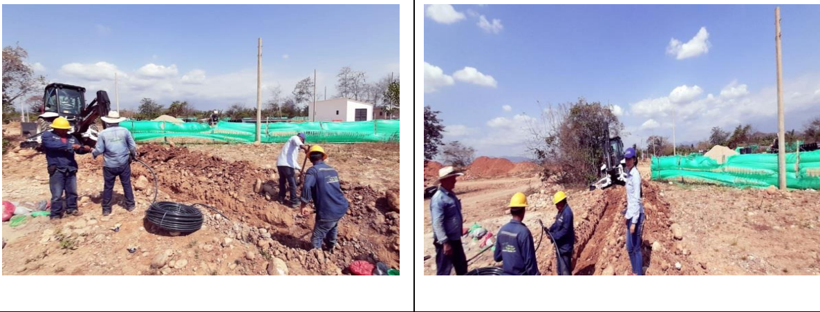
Registro fotográfico: Instalación de acueducto para el cementerio municipal
