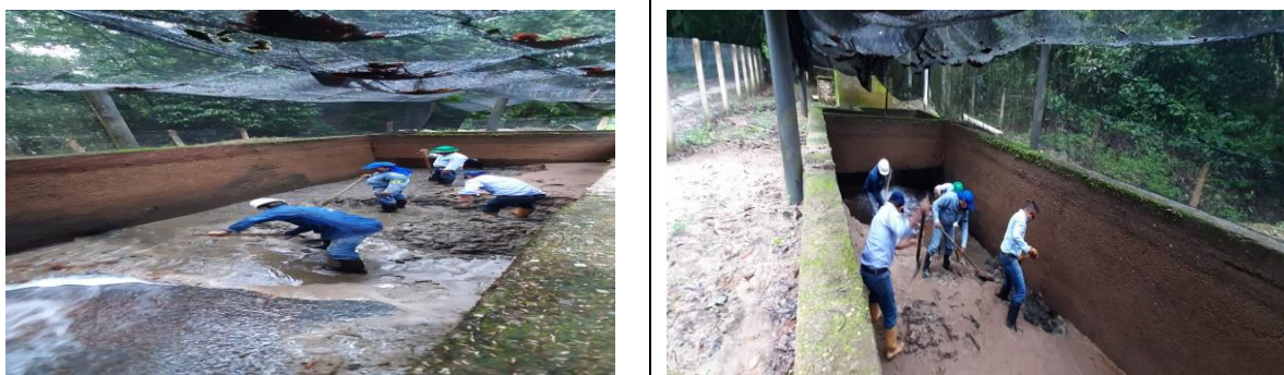
Registro fotográfico: Mantenimiento sistema de captación y desarenador vereda La Motuz
